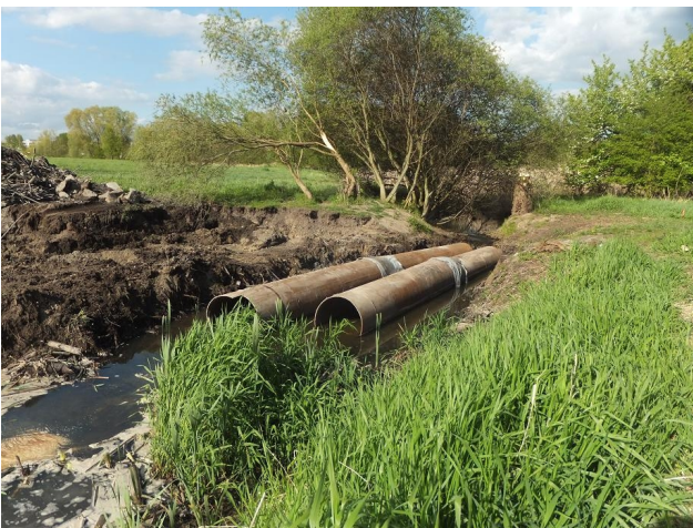
Vorbereitung zur Verrohrung der Wuhle
